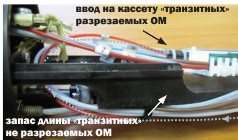
**10.3** Сделав надрезы трубок ОМ стриппером по нанесенным меткам, удалить концы трубок ОМ. Протереть каждое ОВ безворсовой салфеткой (Kim-Wipes), смоченной жидкостью D'Gel, затем салфеткой, смоченной изопропиловым спиртом, после чего протереть ОВ насухо. Произвести временную маркировку пучков ОВ на их концах самоклеющимися маркерами.
