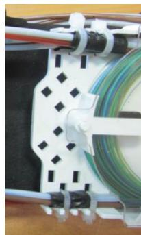
**10.5** Завести на катушку в соответствии со схемой пучок ОВ, входящих в состав ОМ кабеля направления «А».
